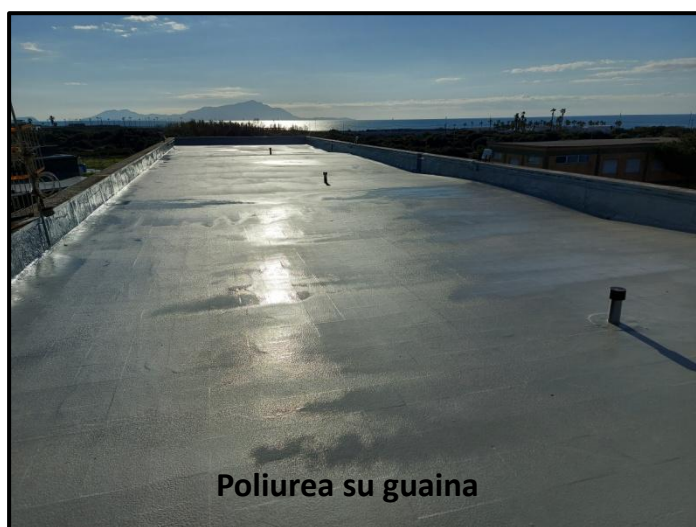
Impermeabilizzazione con applicazione di Poliurea su terrazzo pavimentato senza demolizione
