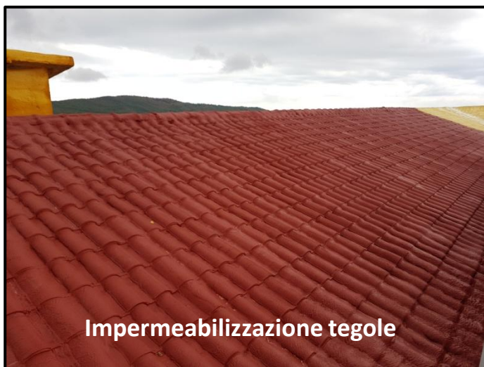
Isolamento e impermeabilizzazione su guaina
